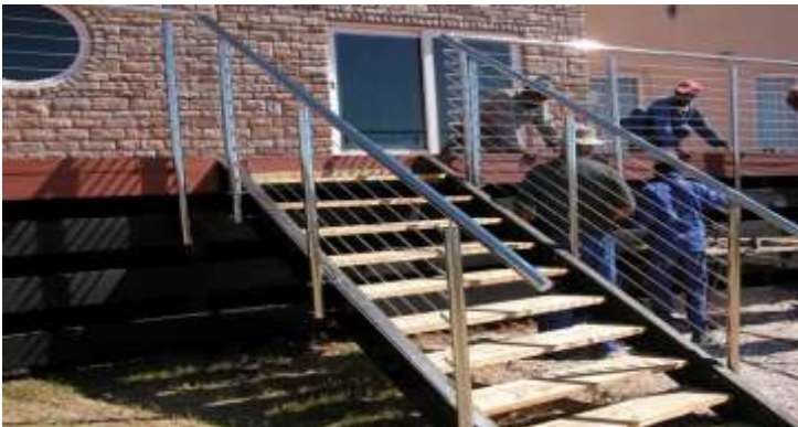
Werkers besig om herstelwerk te doen aan die trappe.
